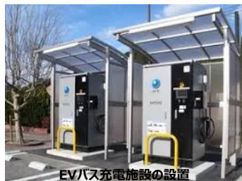
EVバス充電施設の設置
