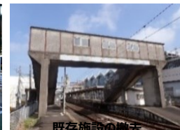
既存施設の撤去
